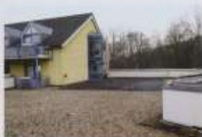
Schon seit Jahren liegen die Pläne in der Schublade. 2017 werden sie herausgeholt und umgesetzt. Statt einer ungenutzten Terrasse auf dem flachen Dach von Küche und Klinikrestaurant wird dort ein Therapiezentrum errichtet.
