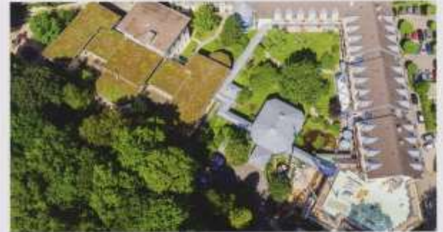
Rechts im Bild ist die Aufstockung Speisesaal im Bau zu sehen. Hier entsteht 2018 eine neue Sport- und Trainingstherapie.
