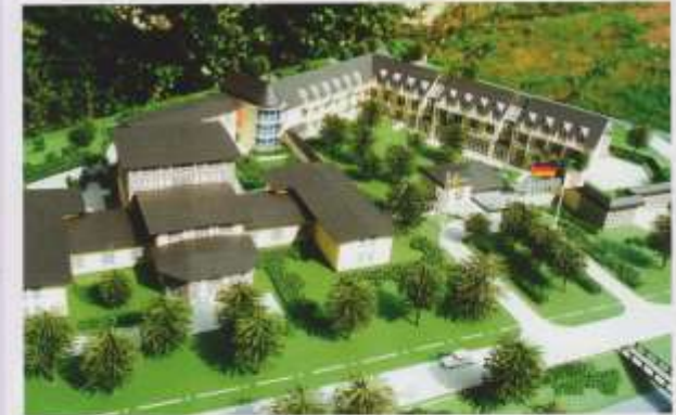
Gebäudekomplex der Sophienklinik Bad Sulza: mitten im Ort und mitten im Grünen gelegen.
