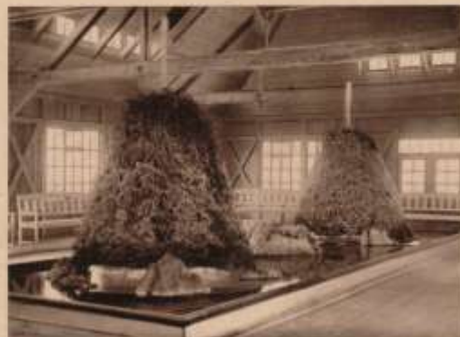
Zerstäuberhalle am Gradierwerk Luise. Innenansicht 7
