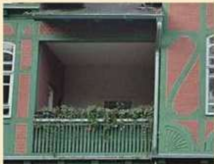
linke/rechte Loggien: wurden im Zuge der Verglasung des unteren Laubengangs verglast
