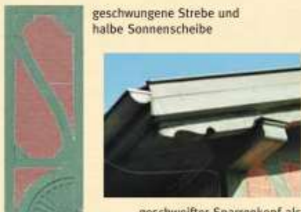
geschwelter Sparrenkopf als „Pferdekopf“ und Pfettenkopf profiliert
