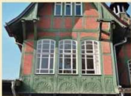
Hauptgiebel mit Sonnenscheiben und gewölbten Sturzriegeln
