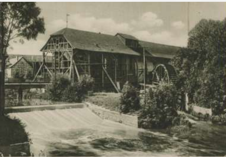
GRADIERWERK LUISE MIT WASSERRAD
