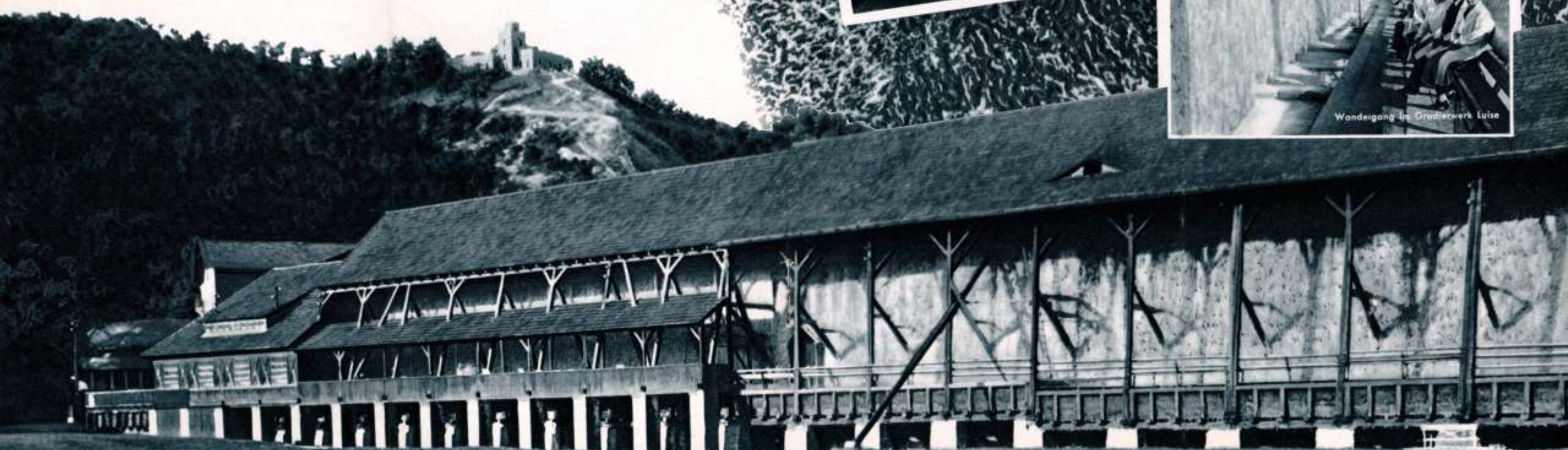
Gradierwerk Luise mit Liege- und Zerstäuberhalle
