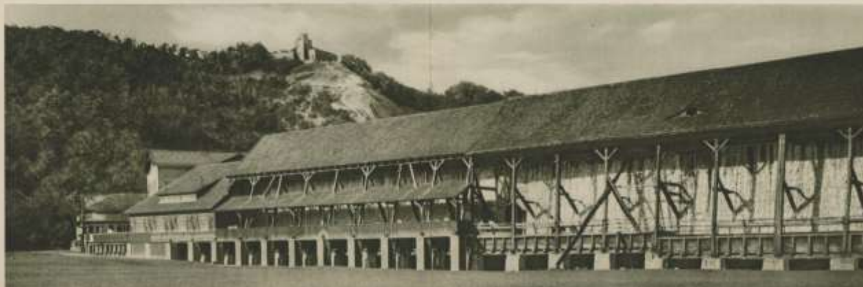
GRADIERWERK LUISE MIT LIEGE- UND ZERSTÄUBERHALLE
