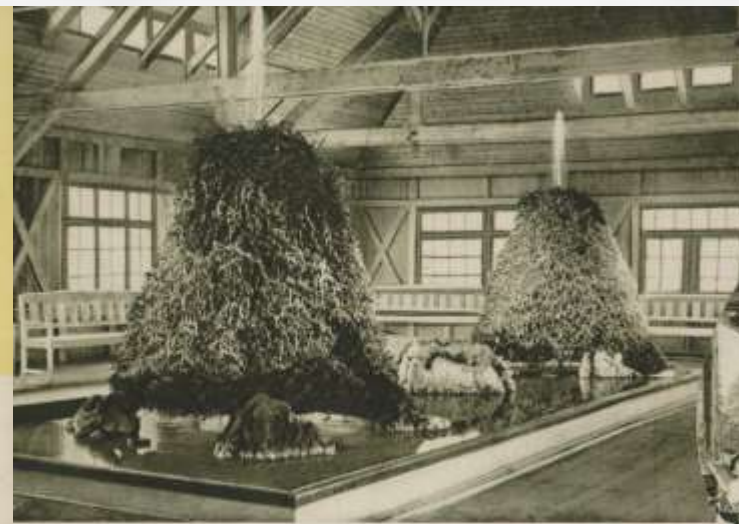
INNENANSICHT: ZERSTÄUBERHALLE GRADIERWERK LUISE MIT 27 1/2 ZERSTÄUBUNG
