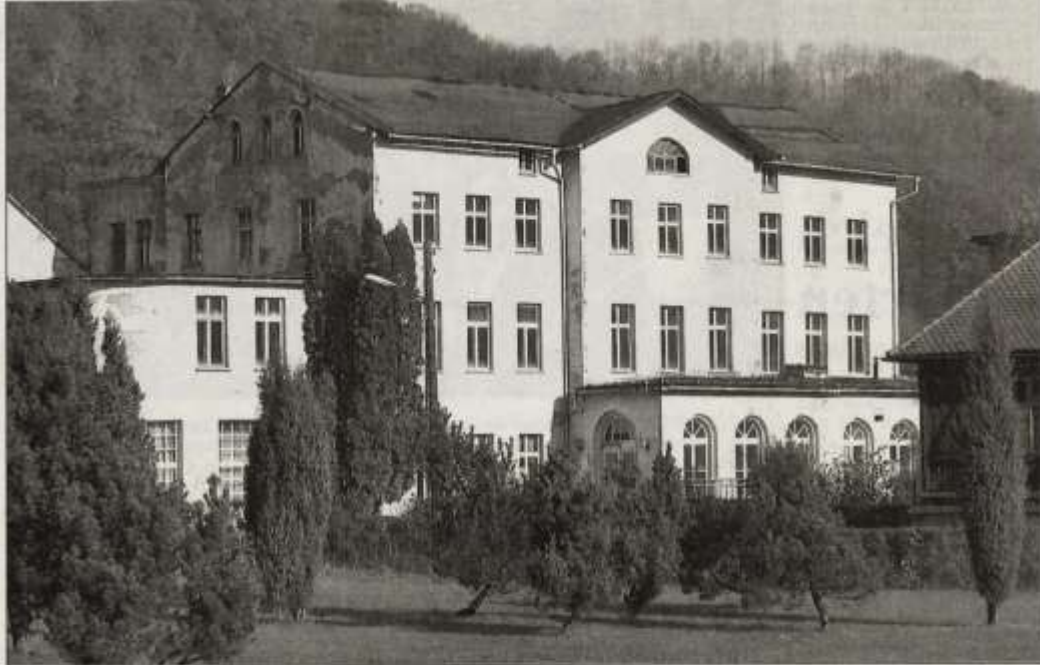
RUINE: Das frühere Kurhotel am Gradierwerk stammt aus der Zeit um die Jahrhundertwende. Bis 1991 brachte Laborchemie hier Monteure unter. Seitdem verfällt das Gebäude und sieht dem baldigen Abriß entgegen. Sanmeda plant hier einen Neubau, konnte sich aber noch nicht zum Kauf des Grundstückes entschließen. TA-Fotos (3): F. SÖLLNER
