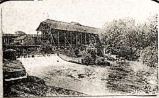
Hauptgradierwerk, unmittelbar bei Schloss Sonnenstein.
