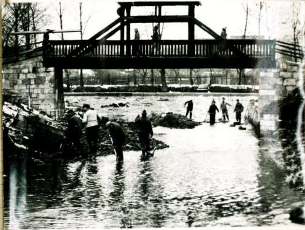
2. Schlackarbeiten und Abstechung des Ufers mit anschließender Verdämmung
