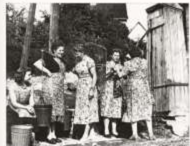
Pumpe am unteren Teich, 1957
