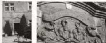
Eingangstür mit Wappenstein, 1994
