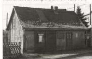
Das alte Feuerwehrhaus, 1951
