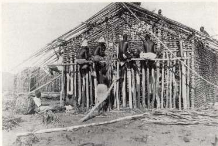
Abb. 69: ... die Harthölzer werden mit Bast verbunden, die Wände mit Lehm verdichtet ...
