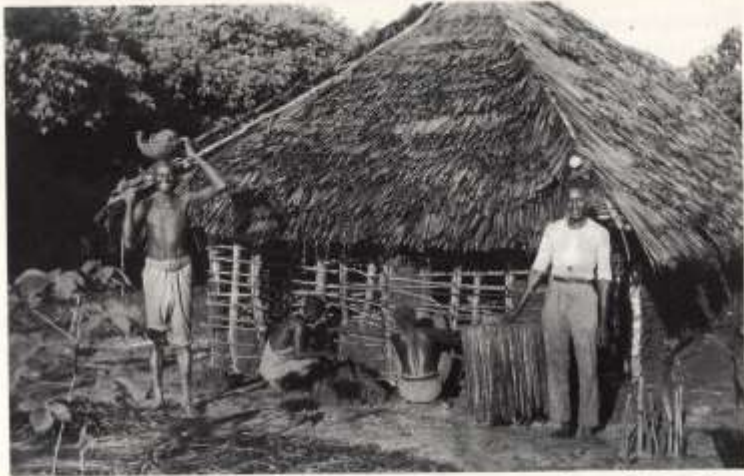
Abb. 51: Bau eines Arbeiterhauses; als Dachbedeckung dienen die Fiederblätter der Kokospalme.
