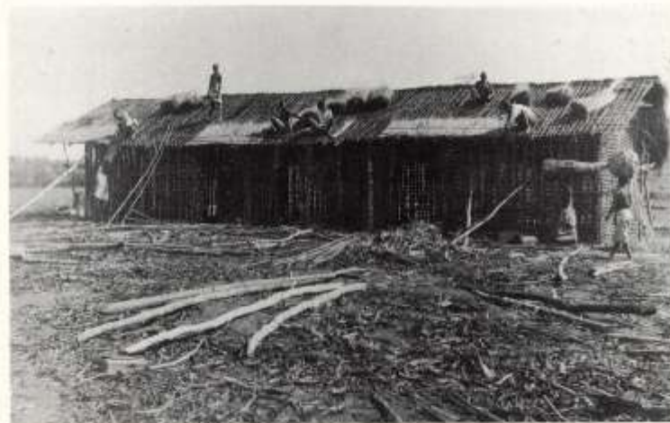
Abb. 70: ... und das Dach mit Gras gedeckt.
