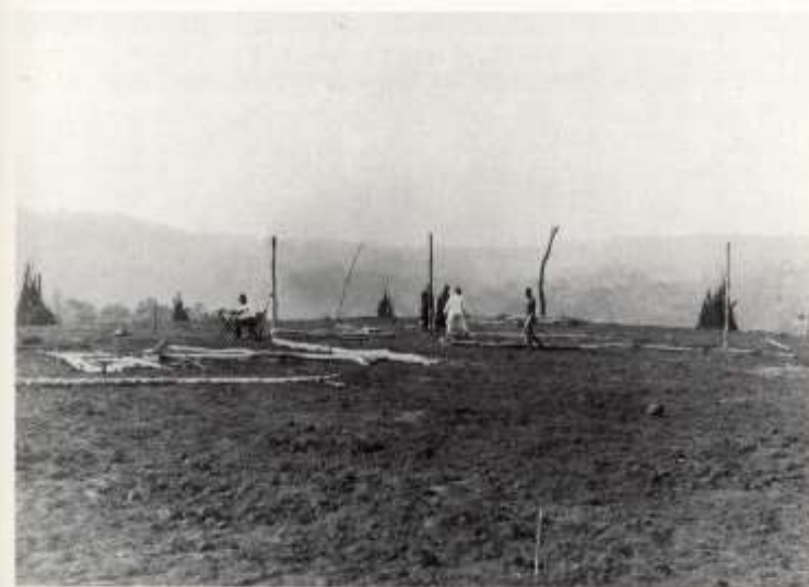
Abb. 68: Das Wohnhaus wird abgesteckt ...
