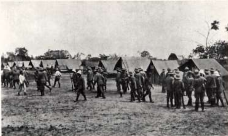
Abb. 83: Beim Lager Bahnstation Pugu: Schützenkompanie ...
