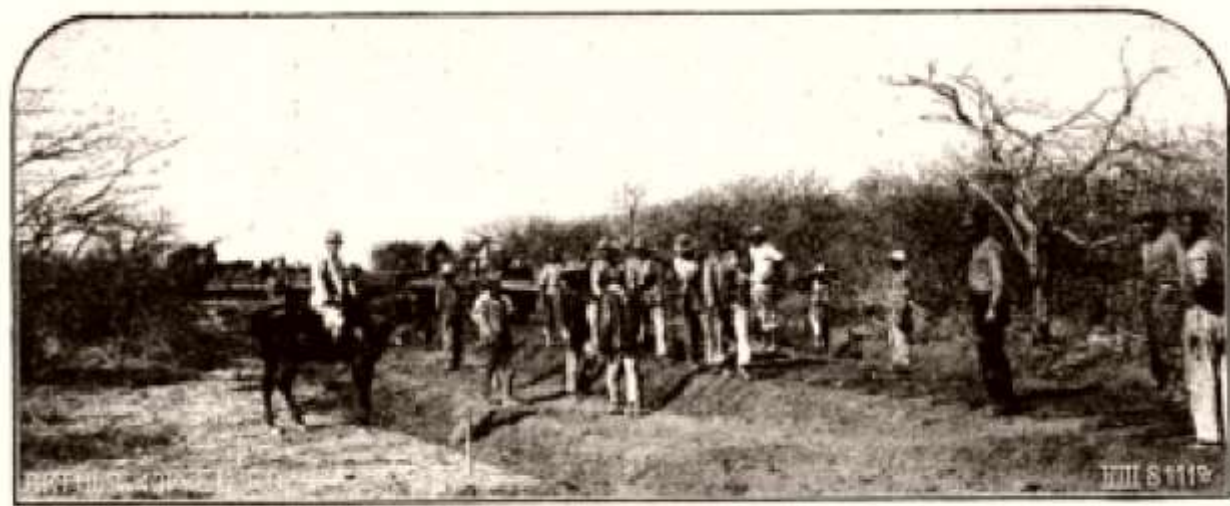
Otavibahn. Vorstrecken des Oberbaues.
